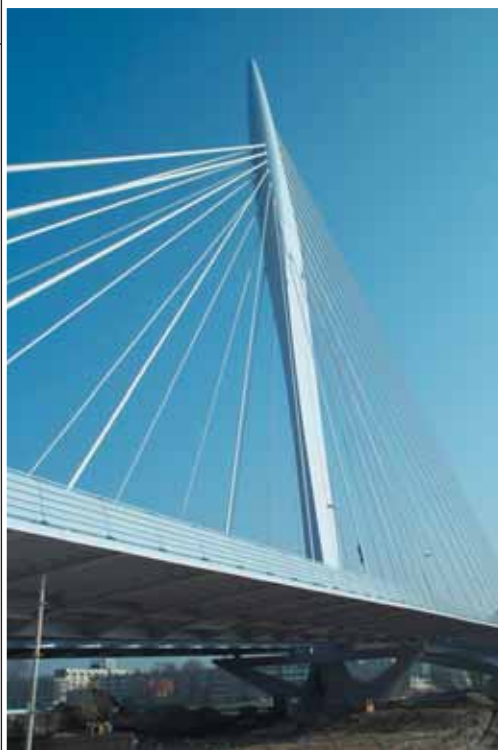
Prins Clausbrug te Utrecht (NL) : pylloon in S460ML (t = 60 mm) _Pont Prince Claus à Utrecht (NL) : pylône en S460ML (t = 60 mm)
