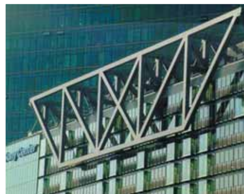
Sony Center te Berlijn (D) – Esplanade: bovenregel in S460ML (t = 110 mm) eindknoop in S690QL1 (t = 100 mm)
