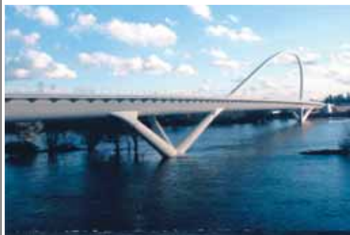
Europabrug te Orléans (F) : boog in S460ML (t = 48 mm) _Pont de l'Europe à Orléans (F) : arc en S460ML (t = 48 mm)
