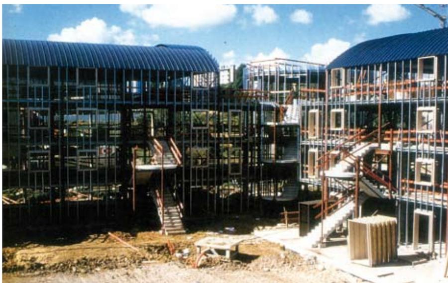
Figure 8.10 Le système PRISM en cours de construction : Ossature en acier, toiture et murs extérieurs en éléments minces prêts à recevoir la peau extérieure
