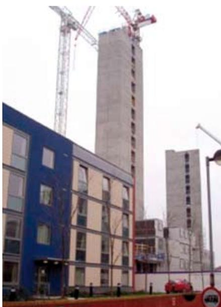
*Modules fixés sur le noyau en béton*
