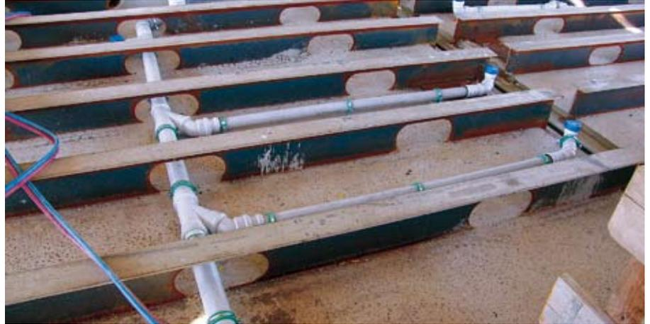
Figure 5.5 Poutres inversées en acier (Slimline) utilisée dans l'immeuble « La Fenêtre »
