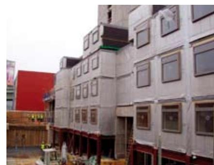
*Installation d'un module sur le podium en acier*
