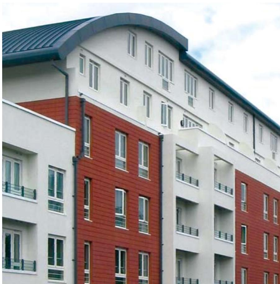
Figure 7.2 *Enduit isolant combiné avec des tuiles en terre fixées sur des murs de remplissage en éléments minces*
