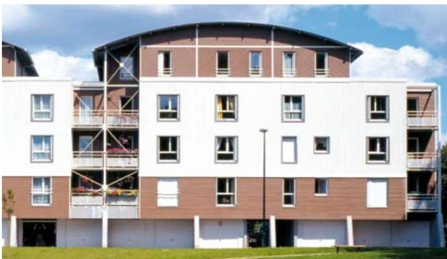
Figure 2.3 Immeuble d'appartements à ossature en acier à Evreux, France, réalisé à partir d'éléments minces en acier associés à des parements légers pour les planchers et les murs Architectes : Dubosc & Landowski
