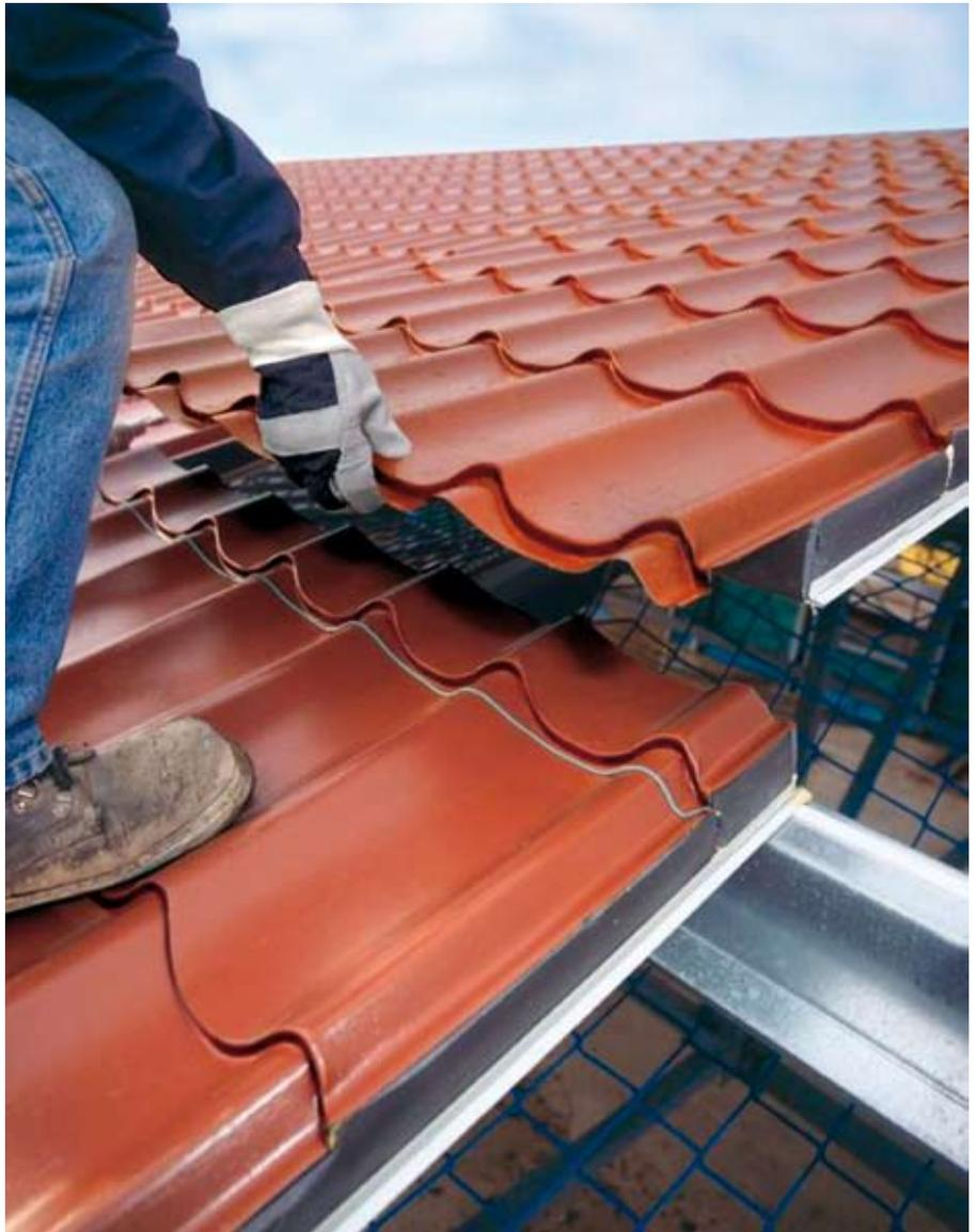
Figure 7.8 *Système de panneaux mixtes à tuiles en cours d'installation*
