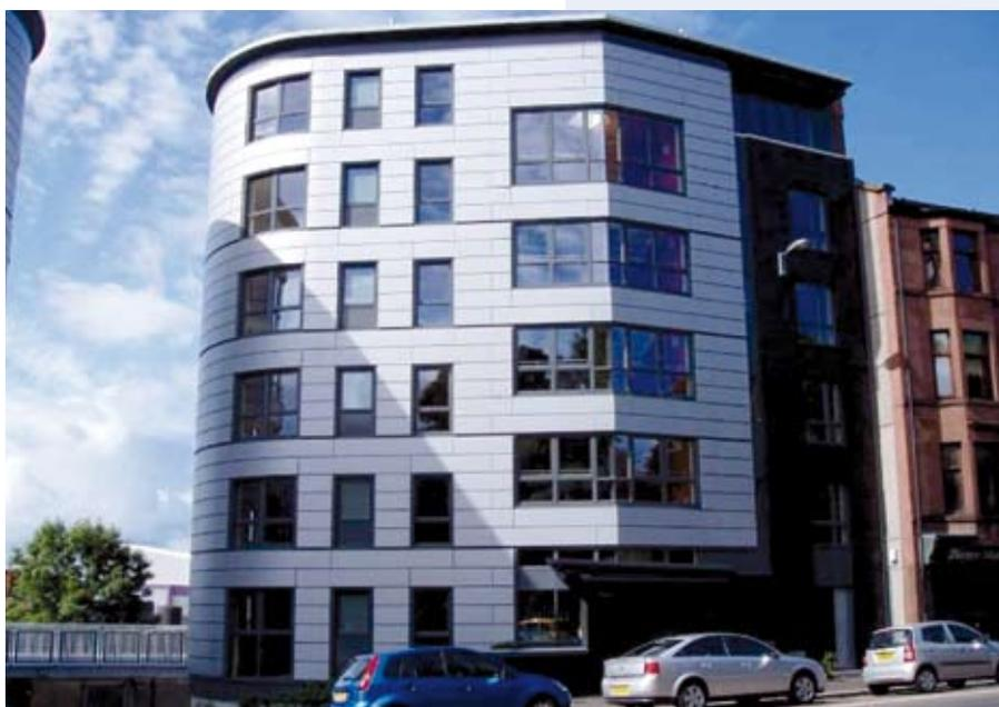
*Figure 7.1* Bâtiment résidentiel avec ossature en éléments minces en acier et habillage métallique à Glasgow
