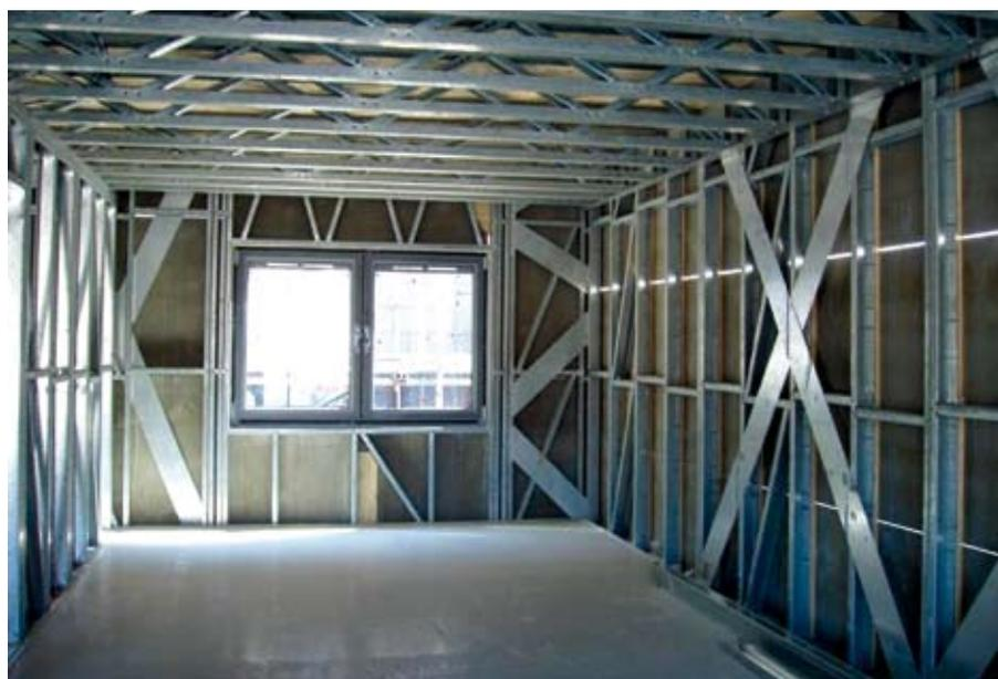
Figure 3.3 Solives en treillis supportant une chape en plâtre utilisées dans les planchers de longues portées
