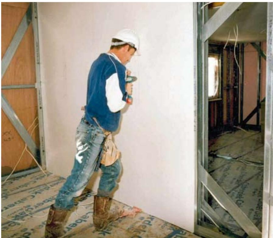
Figure 4.6 Plaques de plâtre en cours de fixation sur un mur de séparation au niveau d'un contreventement en X
