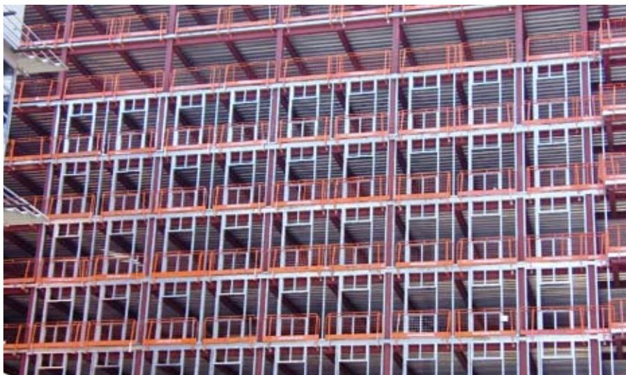
Figure 4.4 Murs de remplissage en éléments minces construits dans une ossature mixte en acier
