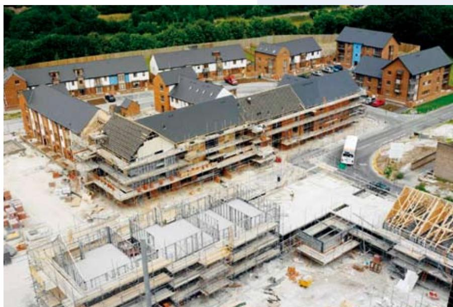
Figure 8.1 *Projet de logement utilisant une ossature en éléments minces en acier (Basingstoke) HTA Architects*
