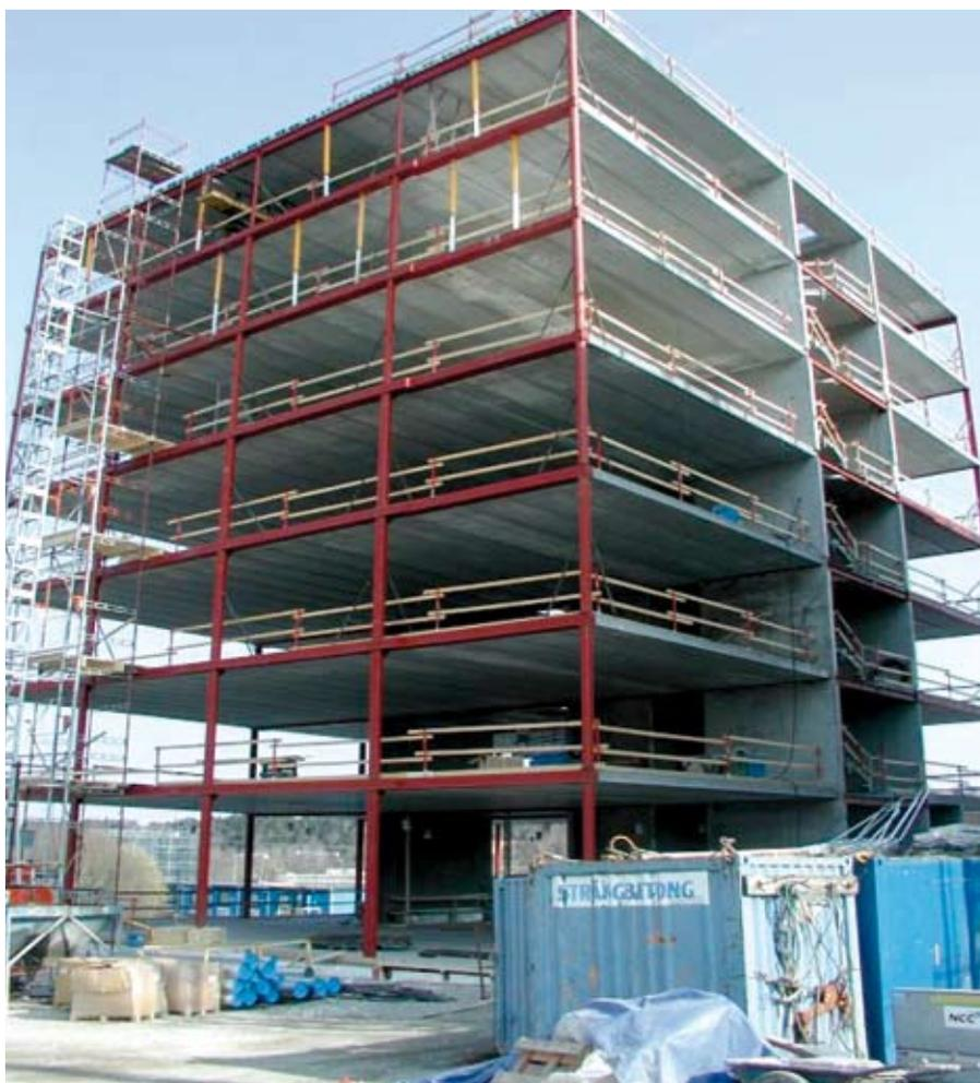
Figure 8.15 Exemple de bâtiment résidentiel de 7 étages avec un système de plancher mince en Suède
