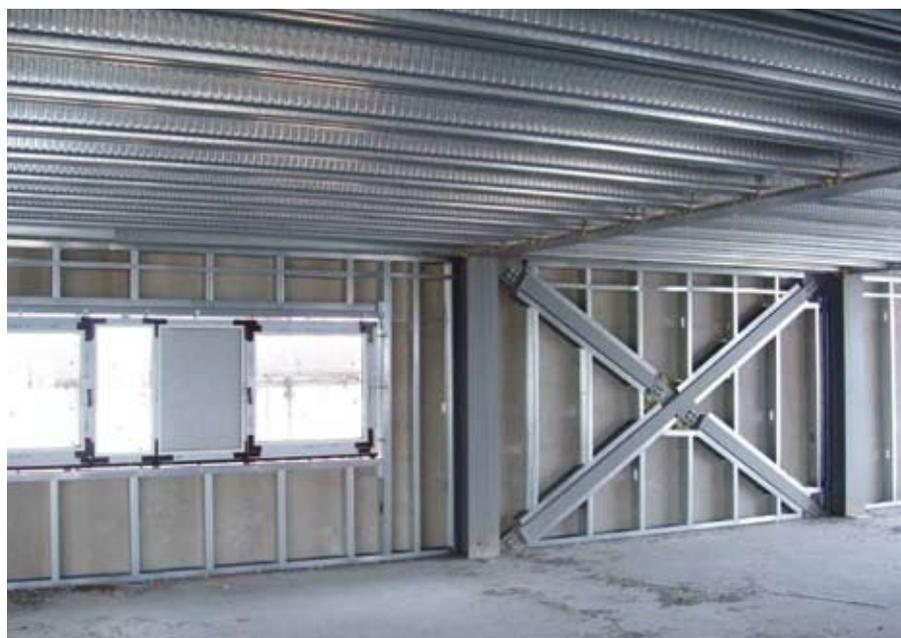
Figure 3.7 Ossature en acier avec plancher mixte de forte épaisseur, poutres ASB intégrées et murs de remplissage
