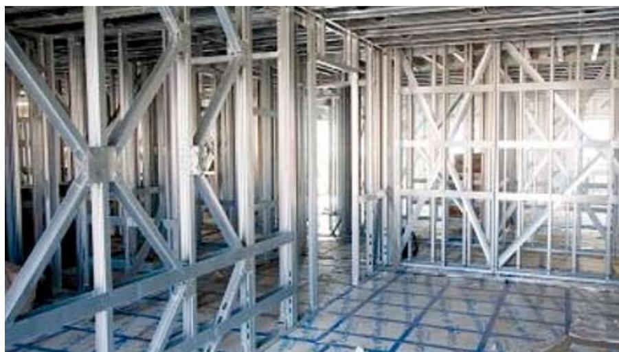
Figure 4.2 Construction en plateforme d'un mur contreventé en éléments minces dans un logement
