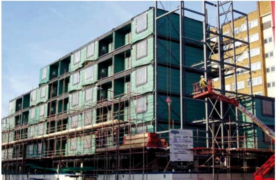
Figure 6.5 *Bâtiment modulaire appuyé sur un podium et stabilisé par une ossature en acier contreventée autour des escaliers*
