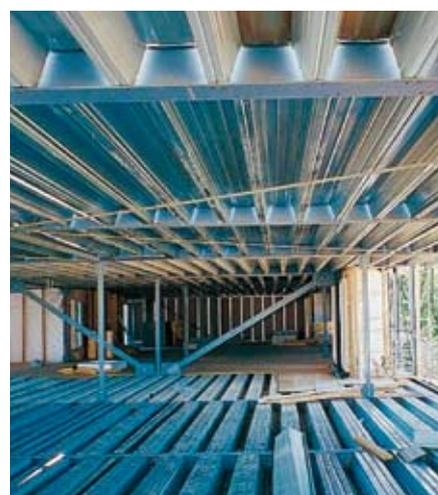
réalisée au moyen de tôles contrées en acier portées par des pannes.
