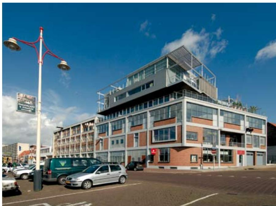
Les nouvelles constructions hors-toit au style architectural verre et acier offrent une vue spectaculaire sur le port. La méthode de construction est un mélange d'ossatures en éléments minces et en acier de construction.
