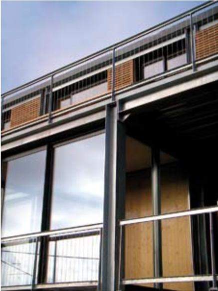
Figure 8.11 *Système PRISM : Exemple d'enveloppe extérieure avec habillage en pierre*
