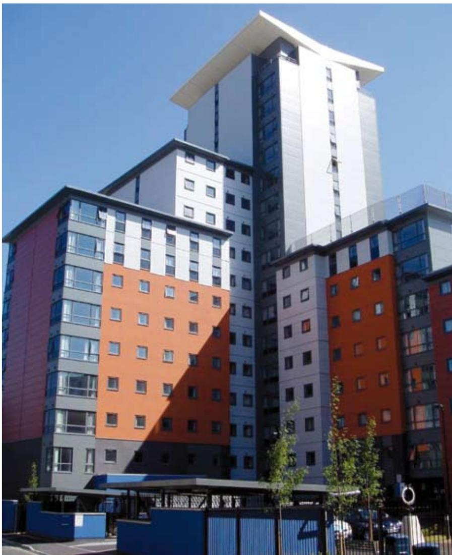
Figure 2.2 Résidence universitaire à 16 niveaux construite au moyen d'une ossature principale en acier et des murs de remplissage en éléments minces en acier (Southampton, R.-U.)
