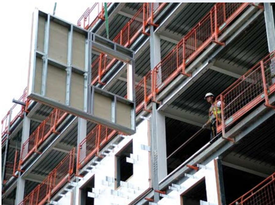
*Figure 4.1 Installation d'une paroi de remplissage en éléments minces dans une ossature en acier*
