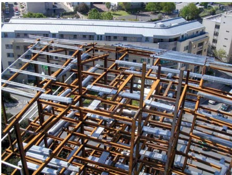
Figure 5.1 Ossature en acier utilisant des profilés asymétrique ASB et des tôles à profils de grande hauteur en cours d'installation
