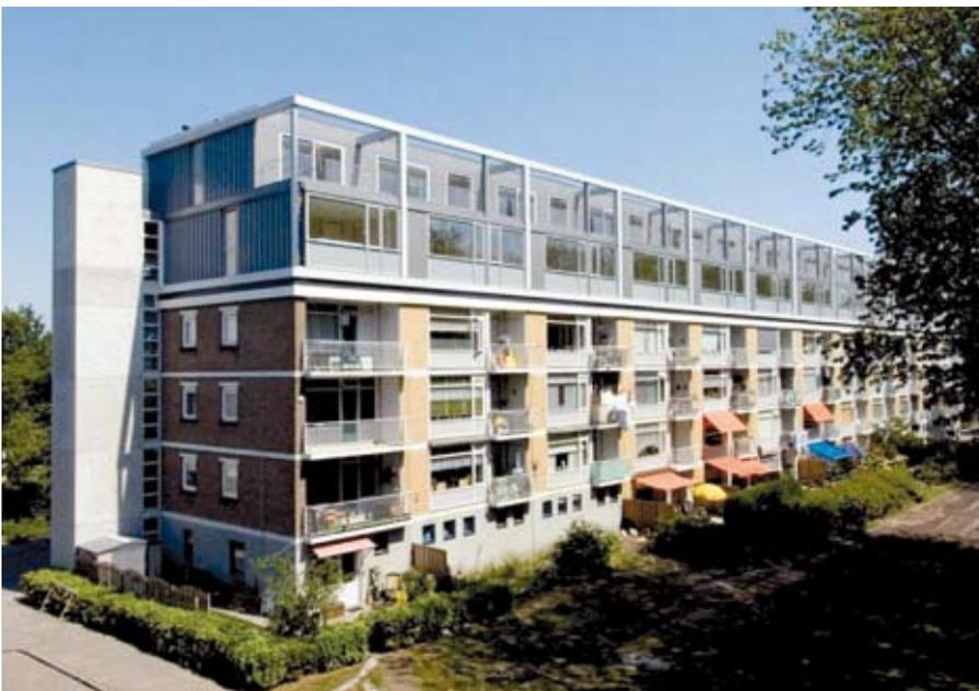
Figure 8.5 Extension hors toit avec appartements duplex : Het Lage Land à Rotterdam
