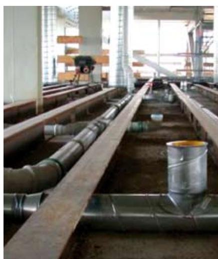
(Droite) Équipements techniques sous le plancher dans le système *Slimline*
