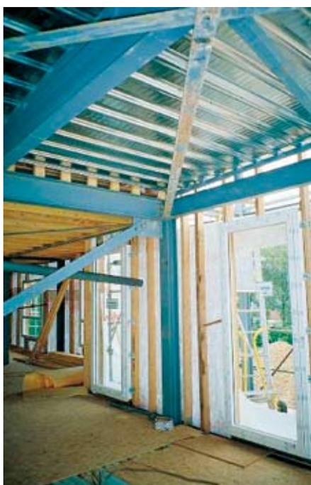
*(Haut) Utilisation mixte de matériaux**(Droite) Plancher intermédiaire montrant le large espace ouvert pour une disposition flexible des cloisons et l'utilisation intensive d'éléments en acier*
