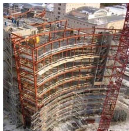
Le Centre Mjärdevi en cours de construction. Ossature principale et éléments minces pour les murs extérieurs
