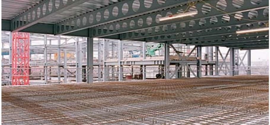
Figure 3.8 Poutres alvéolaires secondaires de grande portée comportant des ouvertures circulaires régulières
