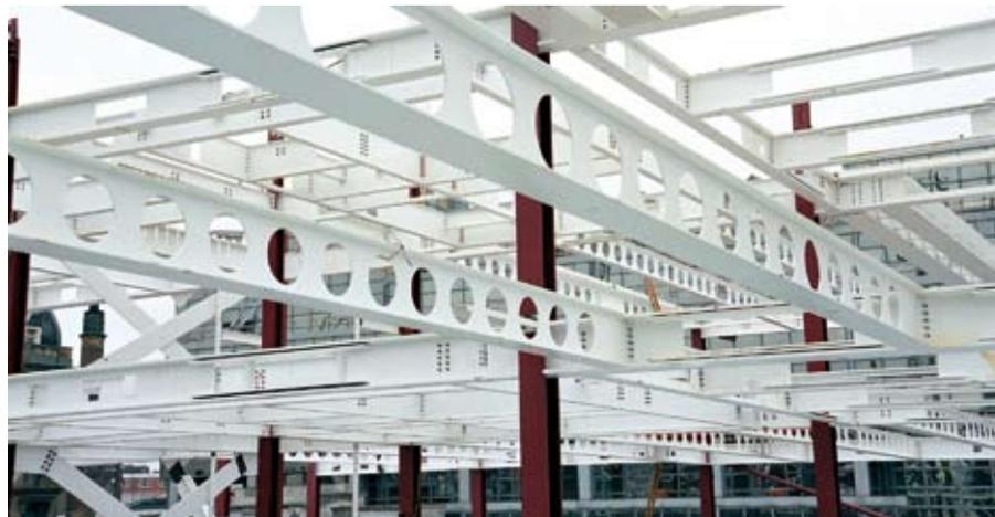
Figure 3.11 Poutres alvéolaires laminées à chaud avec protection incendie appliquée hors chantier
