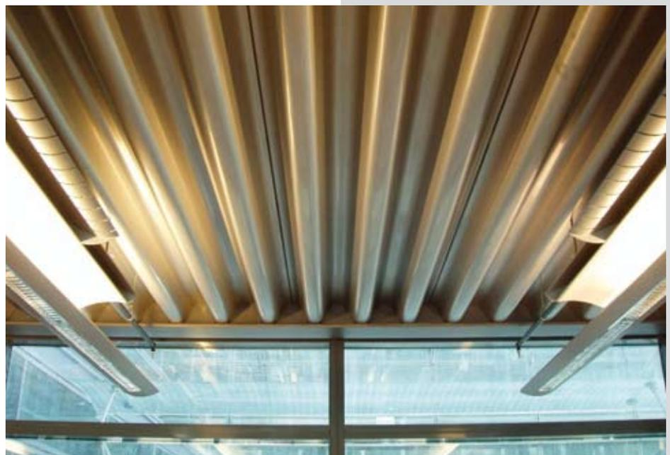
Figure 2.4 Tôles profilées mixtes en acier inoxydable utilisées à la Chambre de Commerce du Luxembourg
