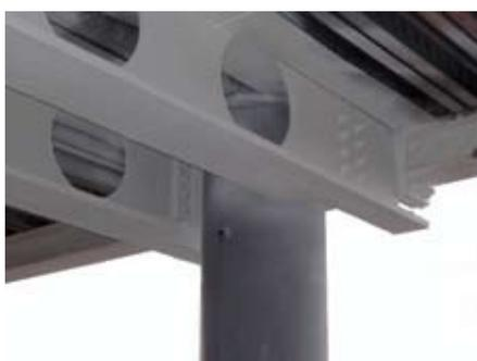
*Assemblage d'un poteau tubulaire*
