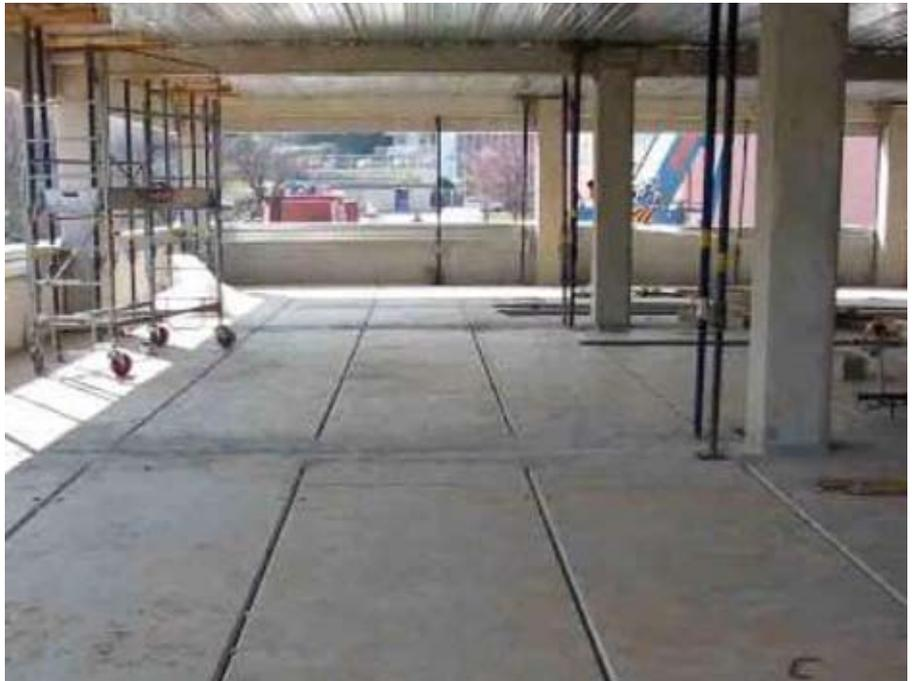
Figure 4.3 *Vue de la dalle Cofradal 200 avant coulage du béton*
