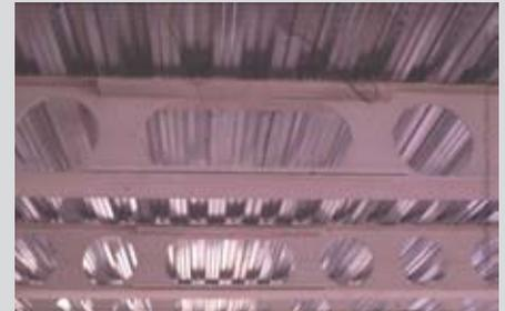
Figure 2.2 Ouvertures oblongues ménagées dans des poutres à raidisseurs horizontaux
