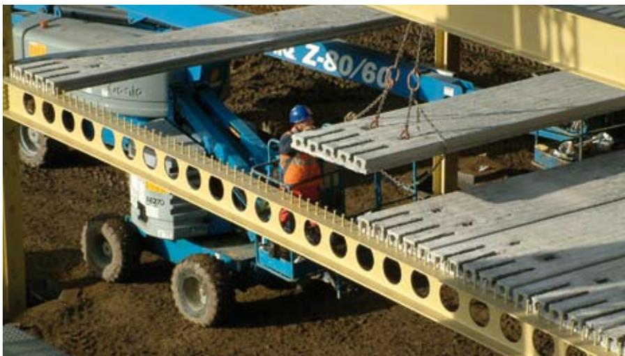
Figure 3.13 Construction mixte d'un plancher réalisée au moyen d'éléments alvéolaires préfabriqués en béton et de poutres alvéolaires
