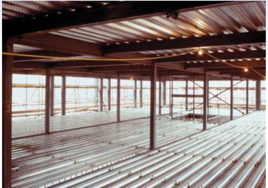
Figure 2.1 Les planchers mixtes constituent une plate-forme de travail sûre pendant la construction
