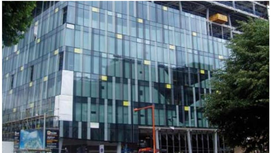
Le bâtiment Palestra de 28.000 m<sup>2</sup> à usage commercial situé dans le quartier de Southwark, à Londres a été dessiné par l'architecte Alsop. L'ossature utilise de nombreux concepts de dimensionnement innovants. L'ossature mixte de 12 étages est constituée de poteaux tubulaires supportant des paires de poutres alvéolaires continues attachées aux poteaux par des cornières.
