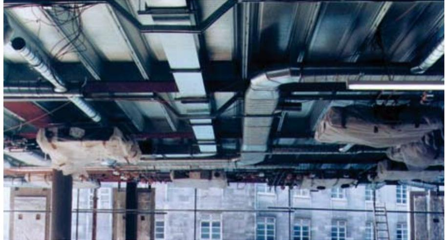
Figure 4.8 Installation des équipements techniques sous le plancher Slimdek
