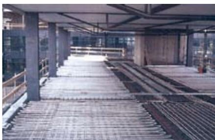
Canalisations de chauffage/refroidissement à circulation d'eau situées dans la dalle de plancher
