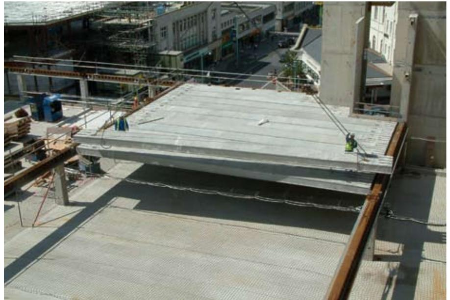
Figure 3.15 *Éléments préfabriqués en béton placés sur des poutres non mixtes*
