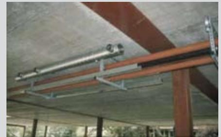
Figure 2.3 Implantation des équipements techniques sous un plancher à poutres intégrées
