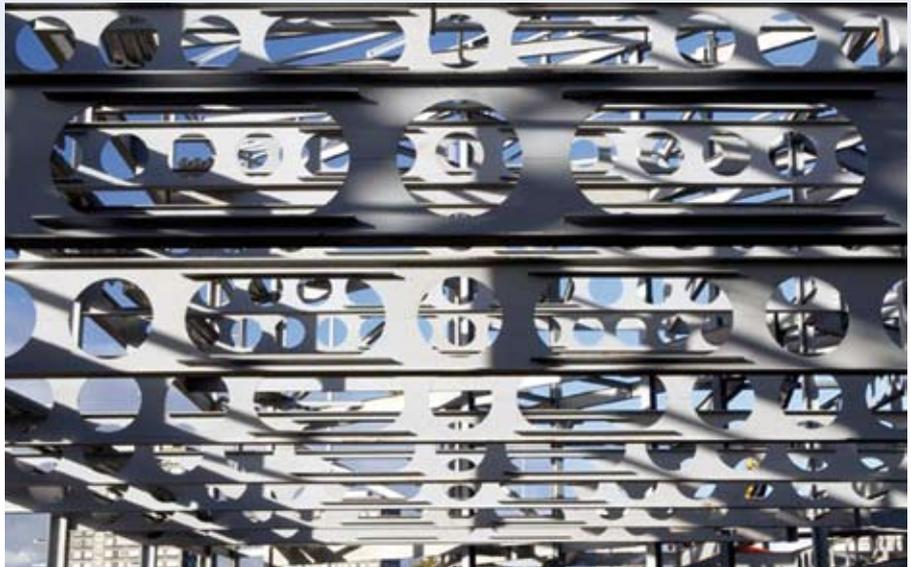
Figure 2.6 Les poutres de grande portée comportant une protection incendie appliquée hors chantier offrent une grande liberté pour l'implantation des équipements techniques
