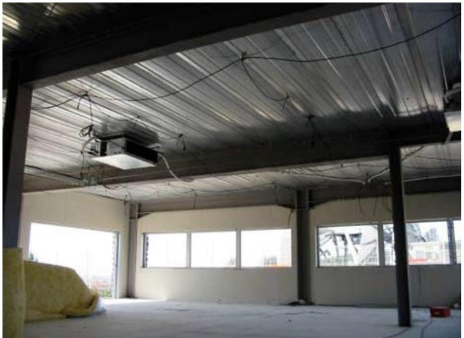
Figure 4.4 *Vue de la sous-face de la dalle Cofradal 200 achevée. Un plafond suspendu est installé pour les équipements techniques*
